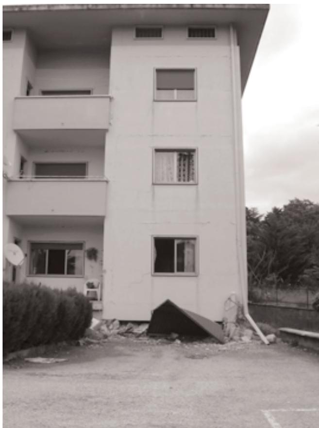
Edificio con il piano terra crollato, è visibile la porta basculante del garage
