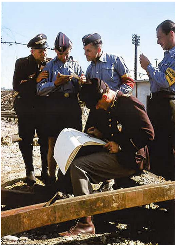
Primavera 1944, linea Bologna – Ancona: militari e ferrovieri tedeschi a rapporto nel corso dei lavori per la riparazione dei danni subiti dalla rete ferroviaria a causa dei bombardamenti alleati. (Fonte: Tutto treno n.230, maggio 2009)
